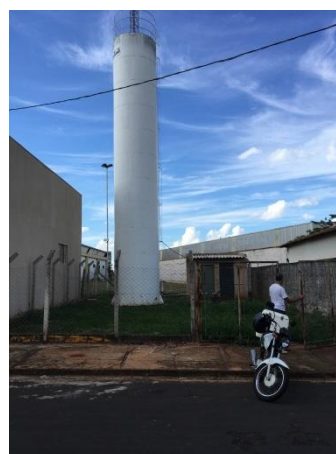
Foto 3.16 - Identificação do Reservatório: Reservatório-03
