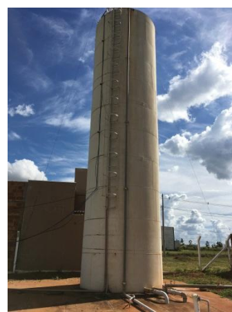
Foto 3.18 - Identificação do Reservatório: Reservatório-05
