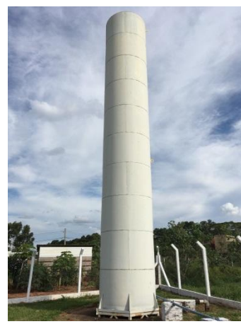
Foto 3.22 - Identificação do Reservatório: Reservatório-08
