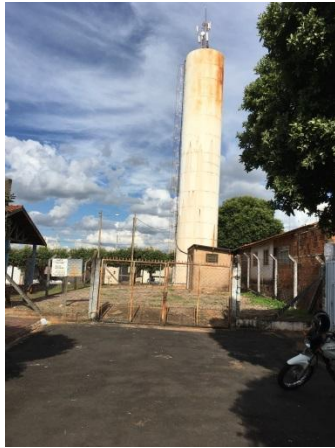
Foto 3.19 - Identificação do Reservatório: Reservatório-06
