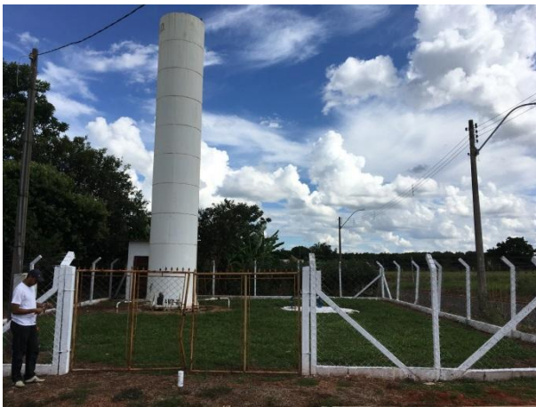
Foto 3.21 - Identificação do Reservatório: Reservatório-07
