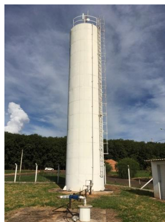
Foto 3.26 - Identificação do Reservatório: Reservatório-13
