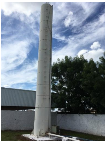
Foto 3.17 - Identificação do Reservatório: Reservatório-04
