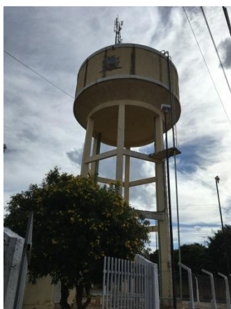
Foto 3.15 - Identificação do Reservatório: Reservatório-01
