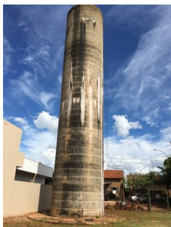
Foto 3.25 - Identificação do Reservatório: Reservatório-11
