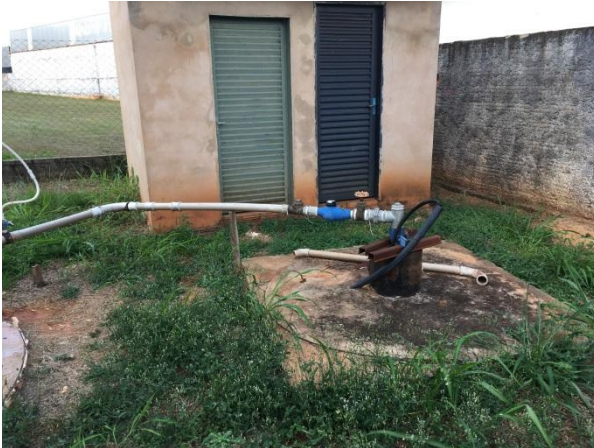
Foto 3.11 - Identificação do Poço: Poço-15
