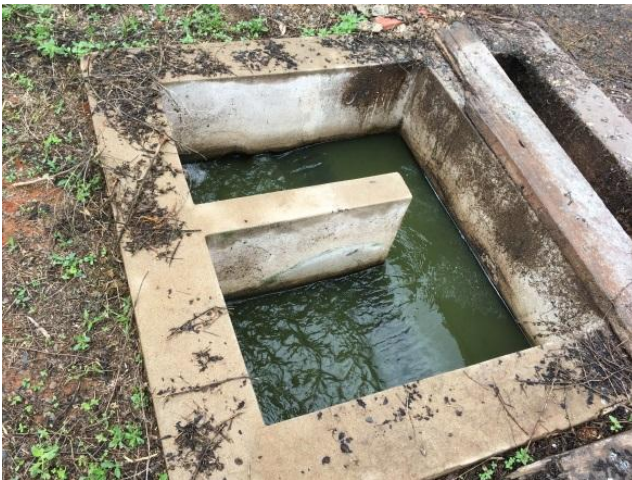
Foto 3.27 – Caixa de Entrada – ETE
