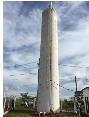
Foto 3.24 - Identificação do Reservatório: Reservatório-10
