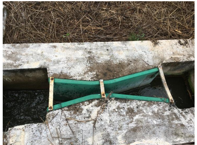
Foto 3.28 – Calha Parshal - ETE
