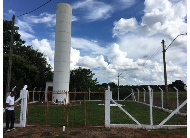
Foto 3.20 - Identificação do Reservatório: Reservatório-07
