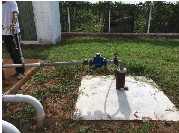
Foto 3.2 - Identificação do Poço: Poço-02
