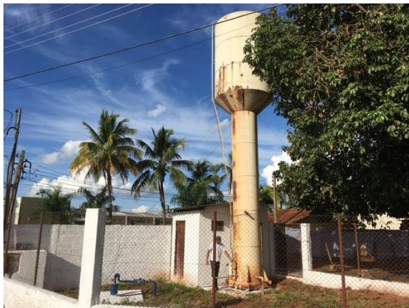
Foto 3.23 - Identificação do Reservatório: Reservatório-09
